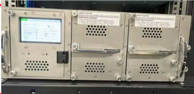
In Rack CDU(ラック毎)
