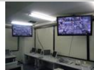
監視オペレーションルーム
