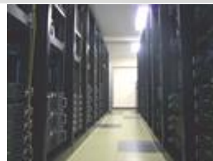
サーバールーム
