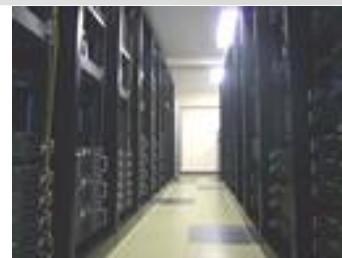
サーバールーム
