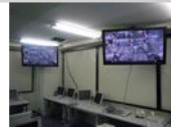
監視オペレーションルーム
